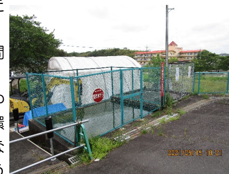
寺方町2区防火水槽
